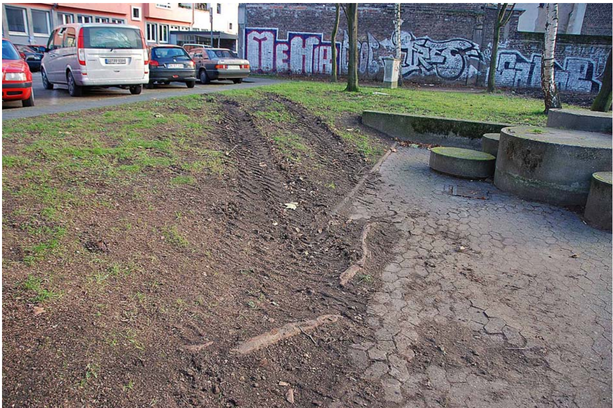
Bild 4: Detail einer Wurzelquetschung
